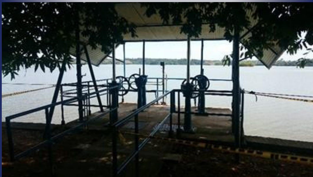
Foto No 2. Zona de Compuertas Bocatoma Acueducto de Barrancabermeja
