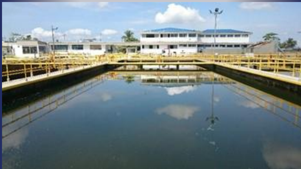
Foto No 3. Zona de Entrada y Sedimentador Lleno de Agua Floculada
