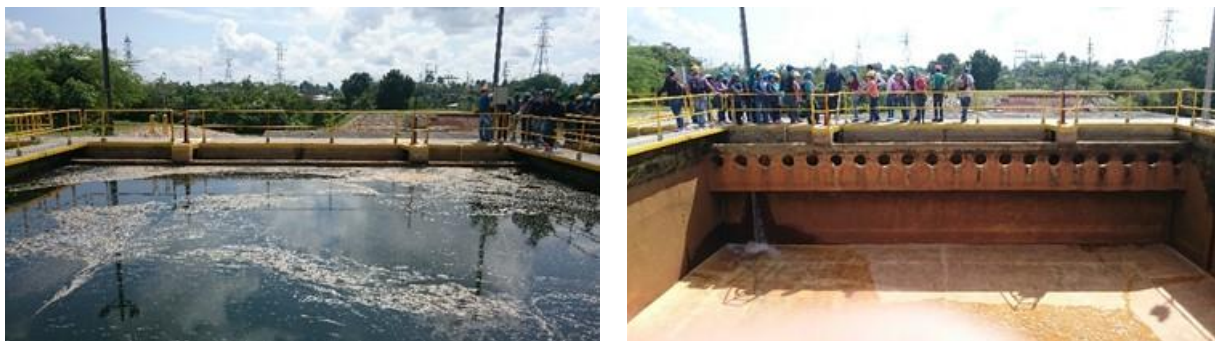
Foto 13. Parte posterior del Sedimentador y zona de salida
