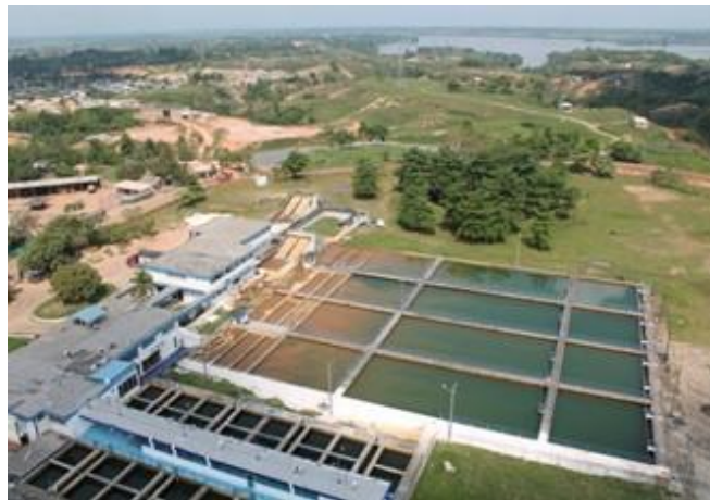
Foto 9. Planta Tratamiento Agua Potable – Barrancabermeja
