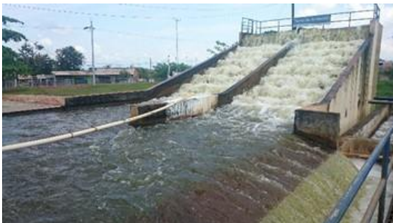
Foto 10. Torres de Aireación
